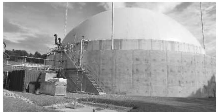
**Flüssigdüngerspeicher mit aufgesetztem Biogasspeicher**
